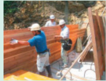
県産材パネル型枠の設置
